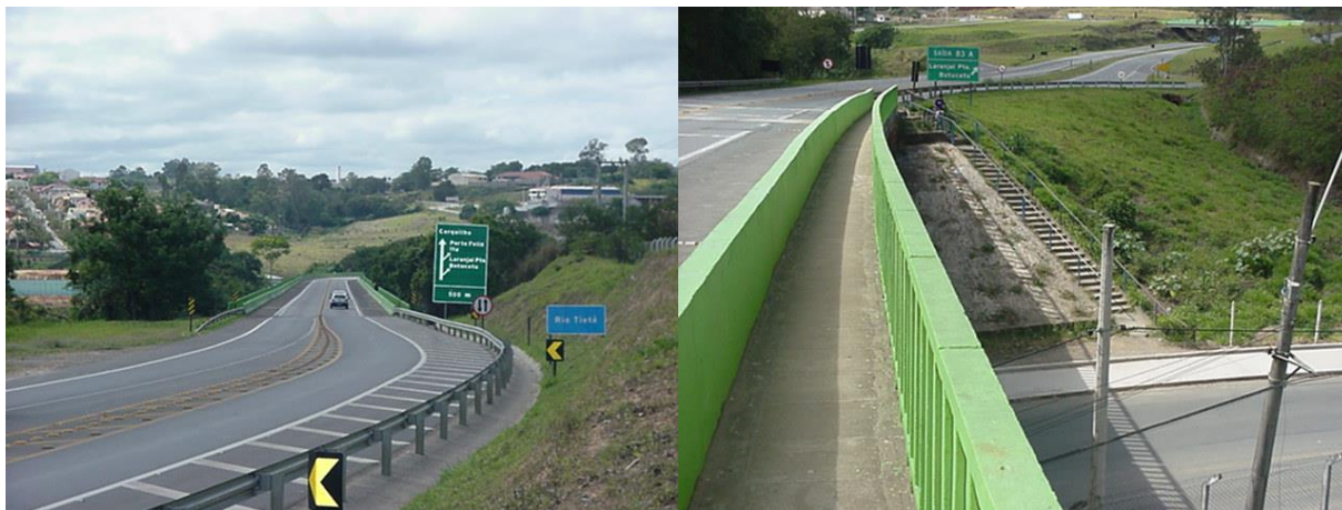
Figura 17 – Ponte SP-127, (esq.) cabeceira norte e (dir.) cabeceira sul. Fonte: Igor E. Borges, 2008
