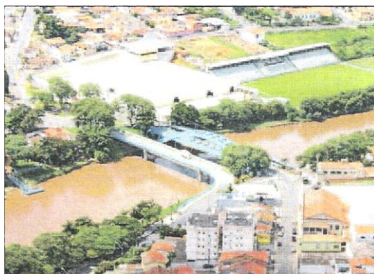
Figura 2 – Ponte de Arcos, a ponte auxiliar e a passarela. Fonte: PREFEITURA MUNICIPAL, 2006
